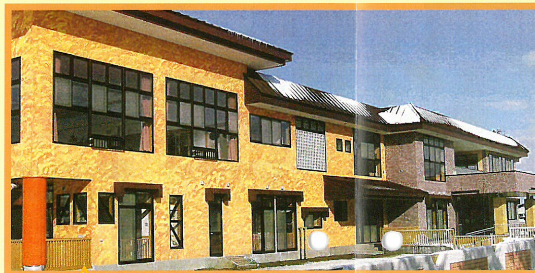
新園舎完成写真
