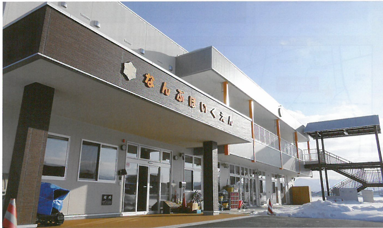
興道南部保育園 新園舎
